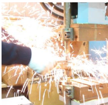
Рис. 9. Сварка арматуры вкрест
